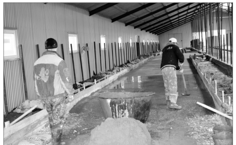
■ Заливка полов на строящейся ферме.
